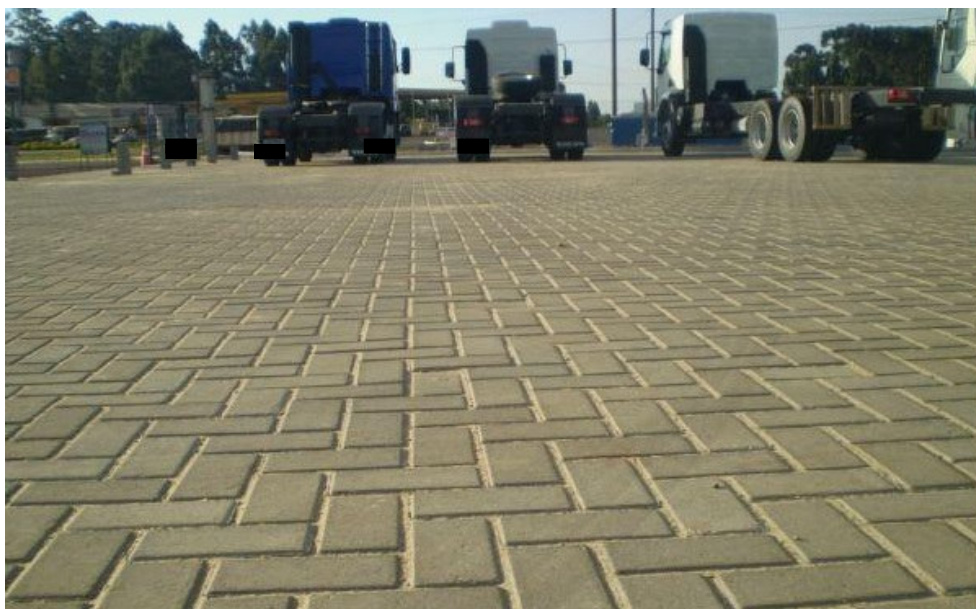
Imagem 1 - Pavimentação com Paver para Tráfego Veículos, Assentamento Tipo Espinha-de-peixe
