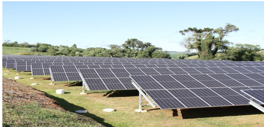
Fotografia 1 – Usina fotovoltaica em implantação no campus Erechim/RS
