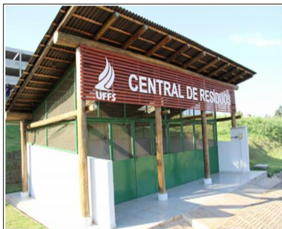
Fotografia 15 – Vista externa da central de resíduos orgânicos e recicláveis.
