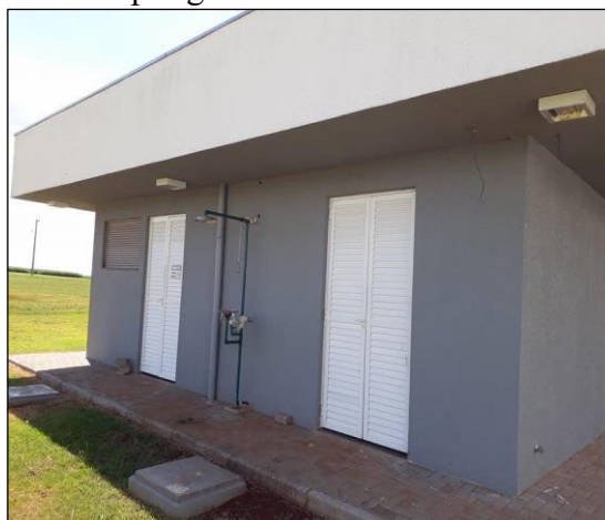
Fotografia 18 – Vista externa do abrigo de resíduos perigosos.
