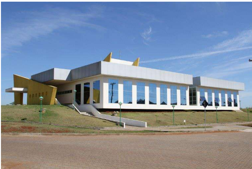
Figura 32 – Restaurante Universitário Campus Erechim/UFFS
