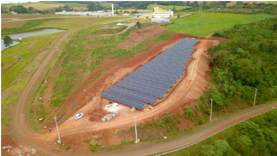
Figura 27 – Trabalhos de implantação da Usina Fotovoltaica no campus de Erechim Fonte: DGA/PROAD/UFFS, 2021
