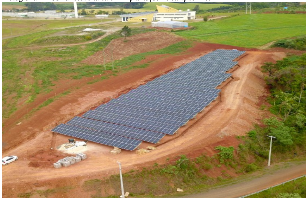
Fotografia 1 – Usina fotovoltaica em implantação no campus Erechim
