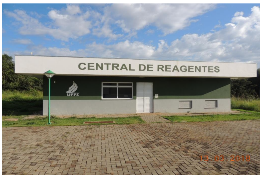
Fotografia 6 - Central de resíduos biológicos e químicos.
