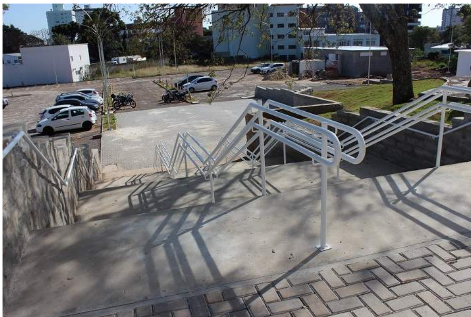
Figura 05 – Conjunto escada e rampa no Campus Passo Fundo
