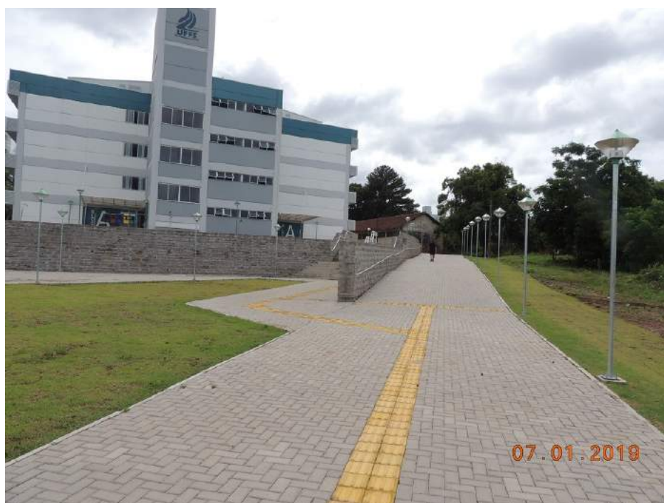
Figura 06 – Conjunto escada e rampa no Campus Passo Fundo
