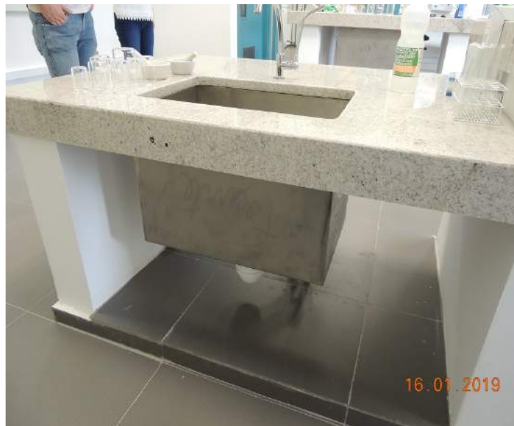
Figura 27 – Bancada em altura adequada, mas inacessível pela profundidade da cuba e pela presença do sóculo no piso, nos Laboratórios do Bloco A do Campus Passo Fundo
