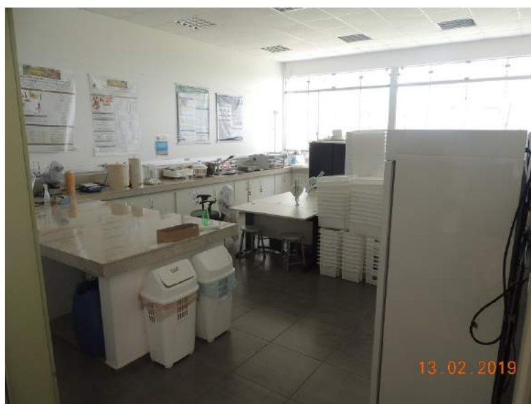
Figura 30 – Mobiliário interferindo na circulação nos Laboratórios Didáticos do Campus Laranjeiras do Sul
