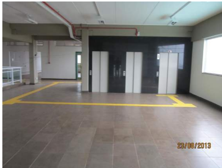
Figura 19 – Circulação de acesso aos elevadores no Bloco A do Campus Cerro Largo
