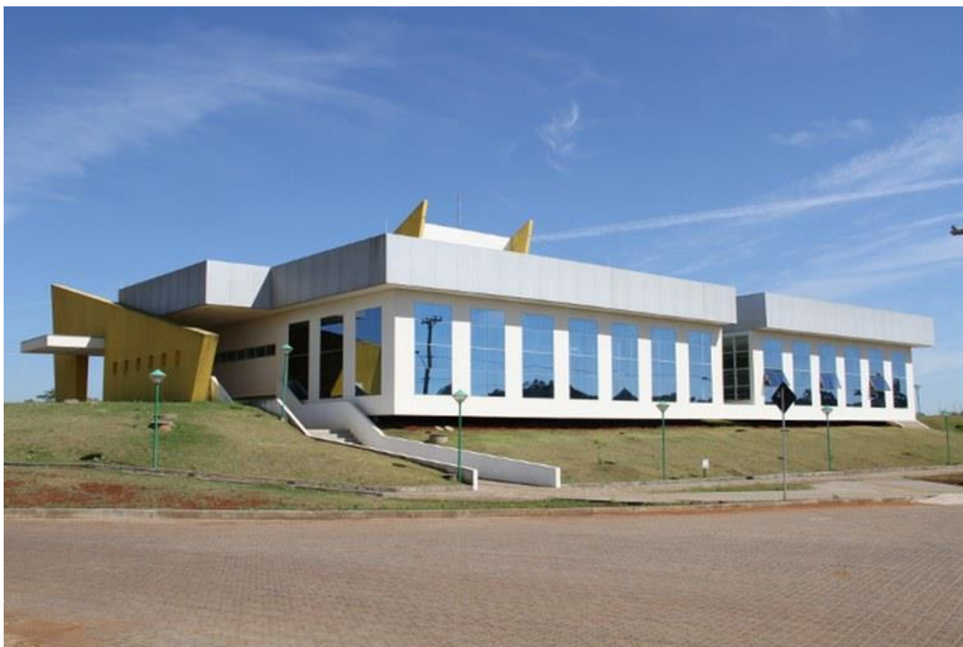
Figura 32 – Restaurante Universitário Campus Erechim/UFFS
