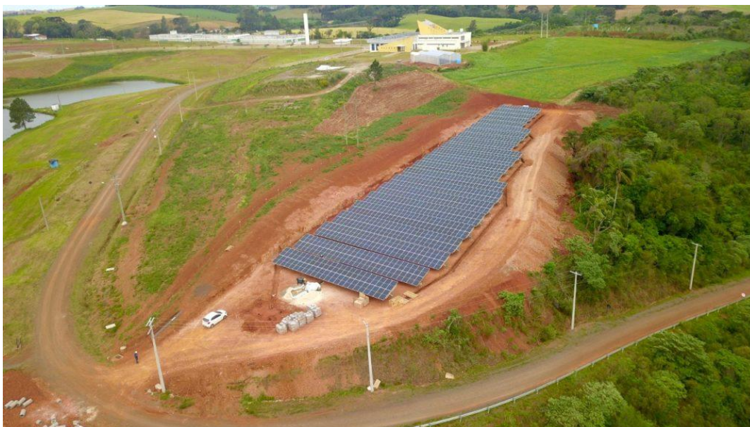
Figura 27 – Trabalhos de implantação da Usina Fotovoltaica no campus de Erechim
